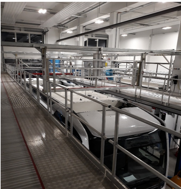
Bild: Dacharbeitsstände Betriebshof VHH, Hamburg Bergedorf
