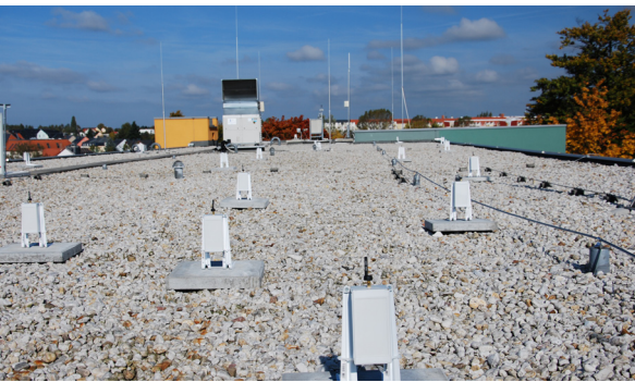
Sensornetzwerk mit 30 Funksensorknoten als Testbed
