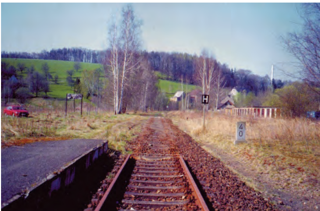
Bild 5: Reste der Chemnitzalbahn 2006
