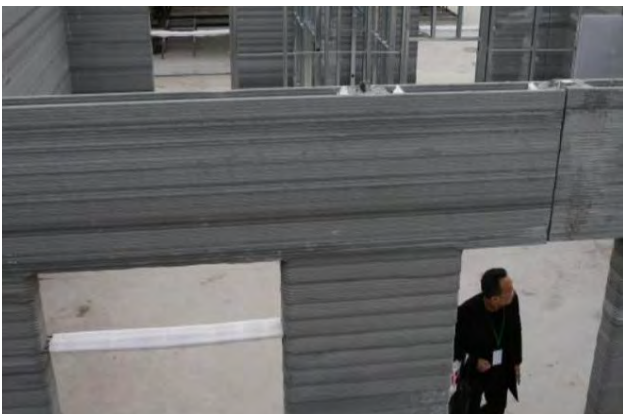
Bild 3: Gedruckte Beton-Fertigteile nach [3]
